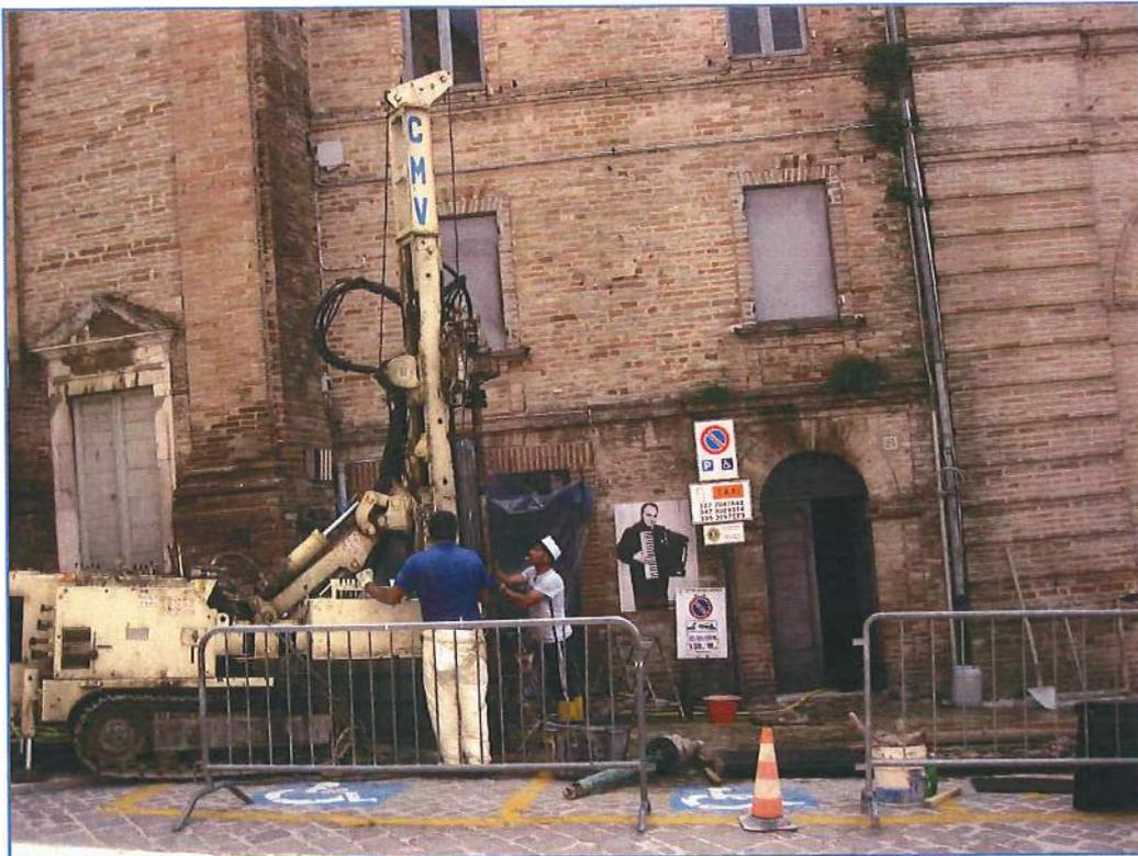
**Foto n. 1: Foto prova SM1 – Postazione sondaggio meccanico a carotaggio continuo**
