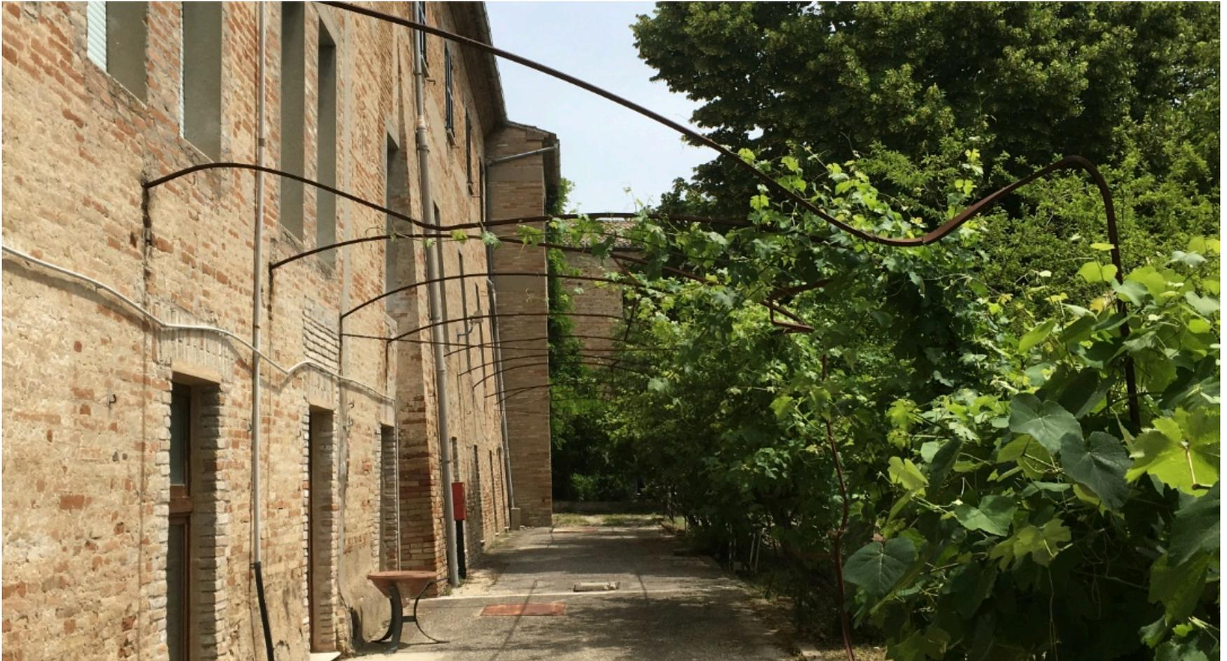
Strutture in ferro degradate, deformate, con elementi di materiale spurio
